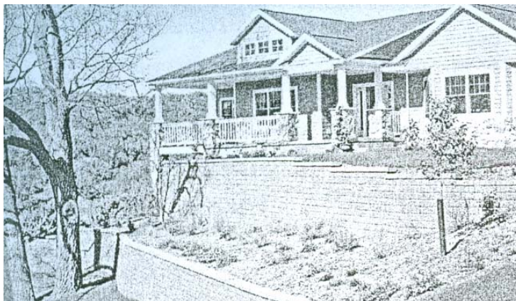
Fig. 14: Imagen de un Muro Segmentado Reforzado con Geomallas
