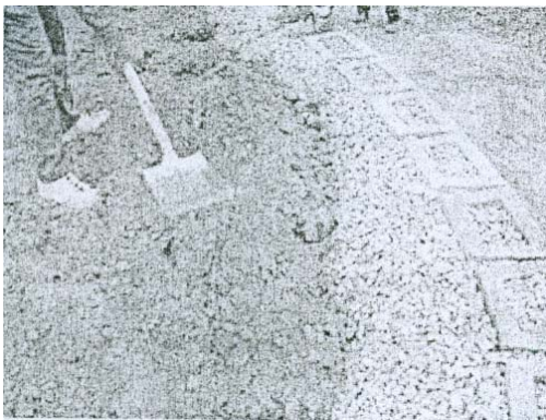
Fig. 11: Drenaje posterior y dentro de los bloques.
