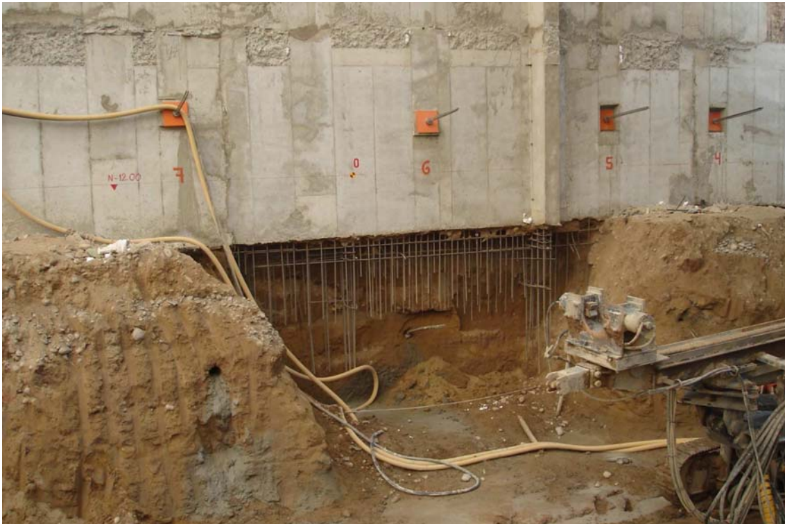
Fig. 1: Foto donde se indica la colocación de refuerzo para futuros empalmes. Fuente ABB Ingenieros EIRL.
