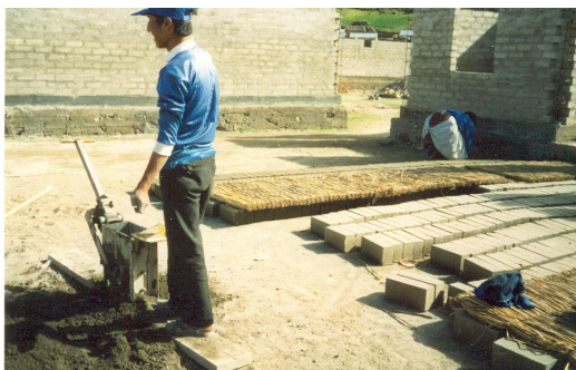
Foto Nº 03: Proceso de curado y secado. Al fondo viviendas construidas
