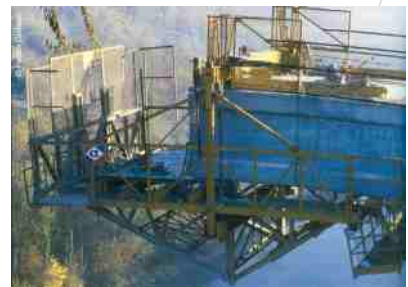
Puente en arco
