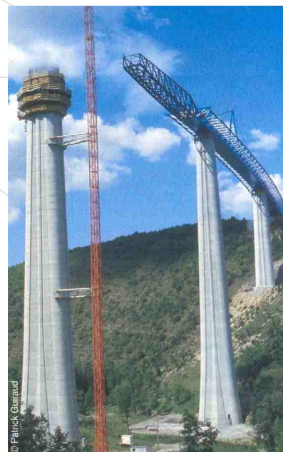
Viaducto de verrières (Autoruta A75)
