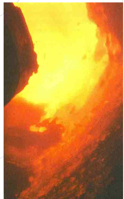
Vista interior de un horno de cemento
