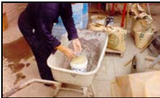
Foto 2.12 Arena utilizada para la construcción de pilas y muretes.
