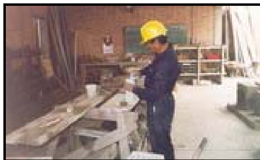
Foto 3.1 Limpieza de los ladrillos usando una escobilla.
