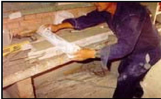
Foto 2.8 Colocación del capping a las unidades.
