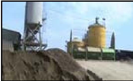
Foto A3 Silo de cemento y tolvas de agregados.
